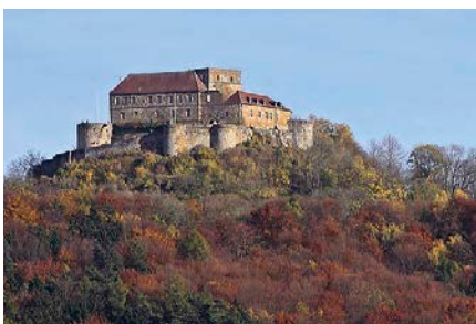
Auch die sanierte Giechburg bietet Fledermäusen Unterschlupf.
